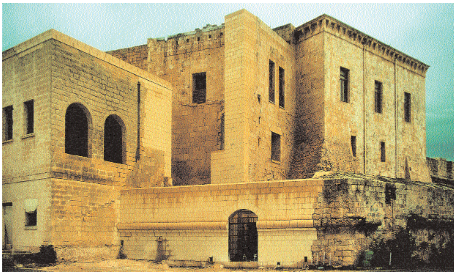
Forte Sant'Angelo, palazzo del Gran Maestro, prima del restauro e a lavori ultimati (A.D.C.)
